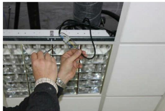
Desconecte la "regleta" de conexión del panel a sustituir
